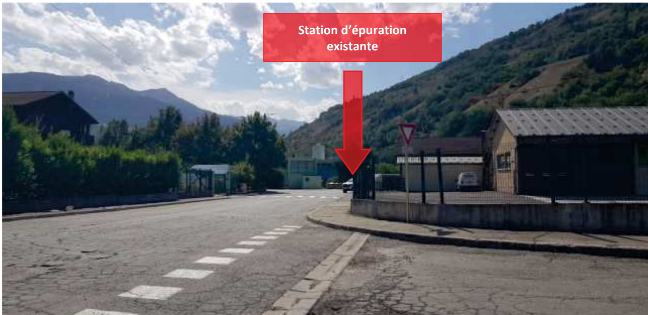
Figure 15 : Entrée de la station d'épuration existante vue depuis l'Allée des Rives au droit de l'habitation la plus proche (prise de vue 6 septembre 2022)
