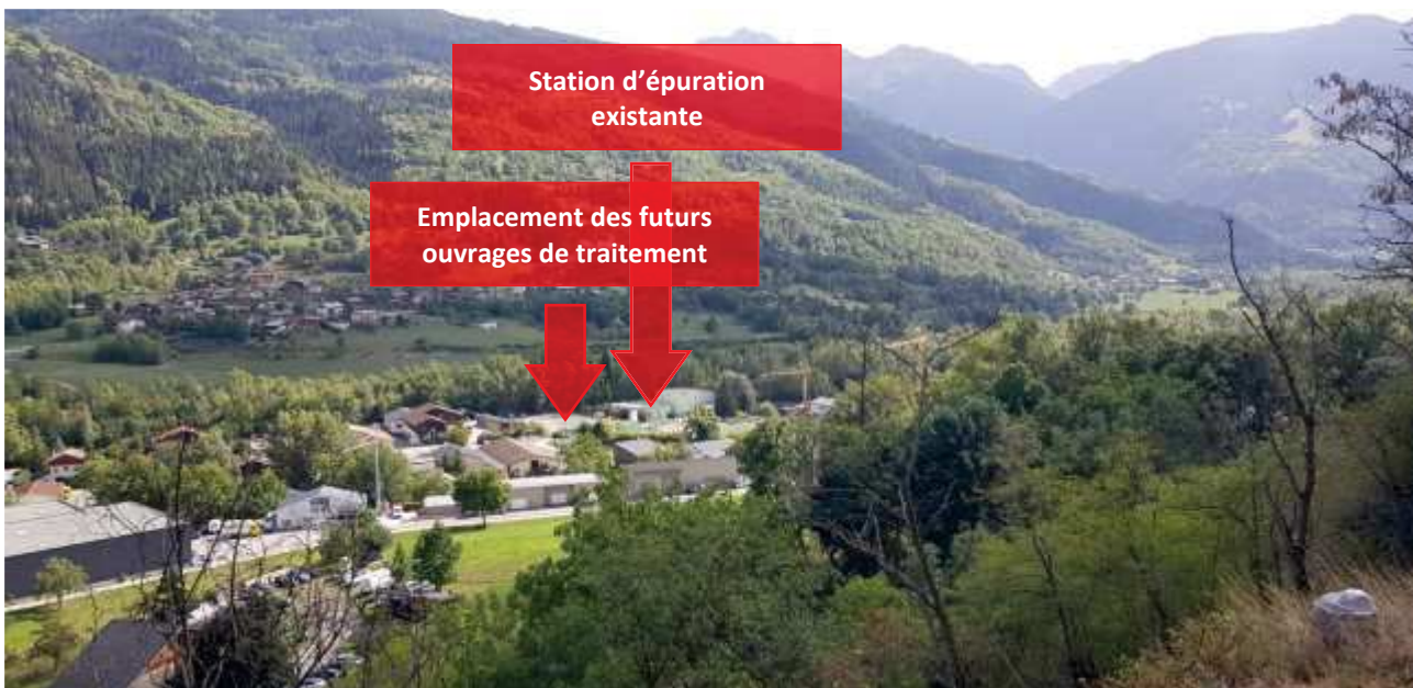
Figure 16 : Station d'épuration existante et site d'extension vus depuis la RD1090 (prise de vue 6 septembre 2022)
