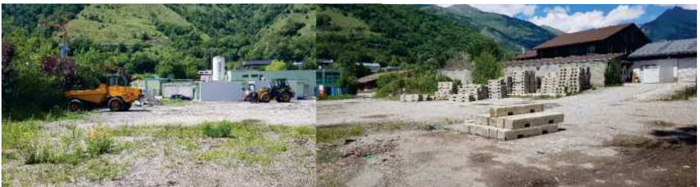
Figure 12 : Sites de la station d'épuration et de son extension vus depuis la ripisylve de l'Isère
